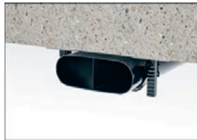
Flachkanal an der Kellerdecke
